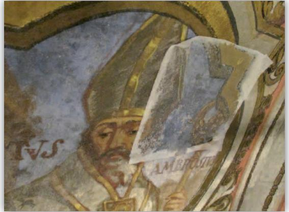
Consolidación del muro que tenía problema de desprendimiento, con inyección de mortero. Parte de este que se había desprendido por movimiento y desgarramientos de humedad.
